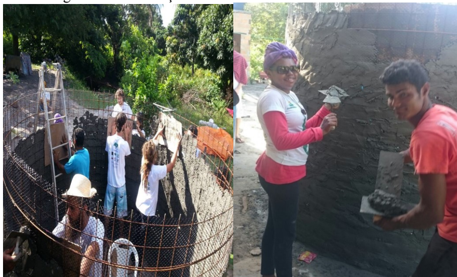
Figura 03 - Construção uma Cisterna de Ferrocimento
